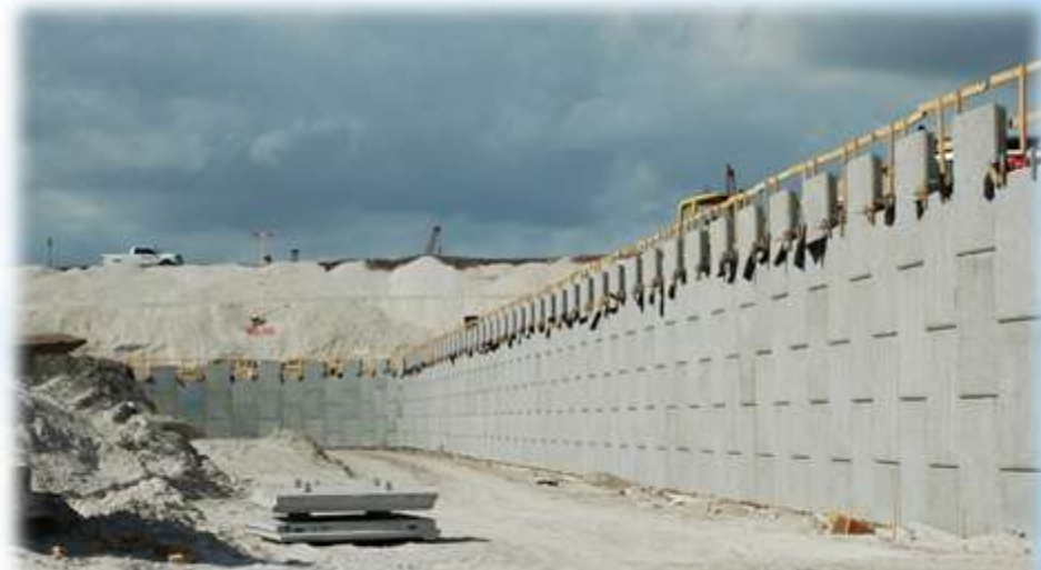
Runway MSE Wall
